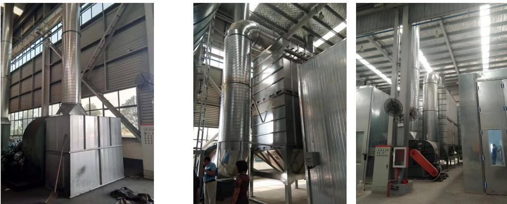
活性炭吸附+15 米排气筒      脉冲布袋除尘器+15 米排气筒排
